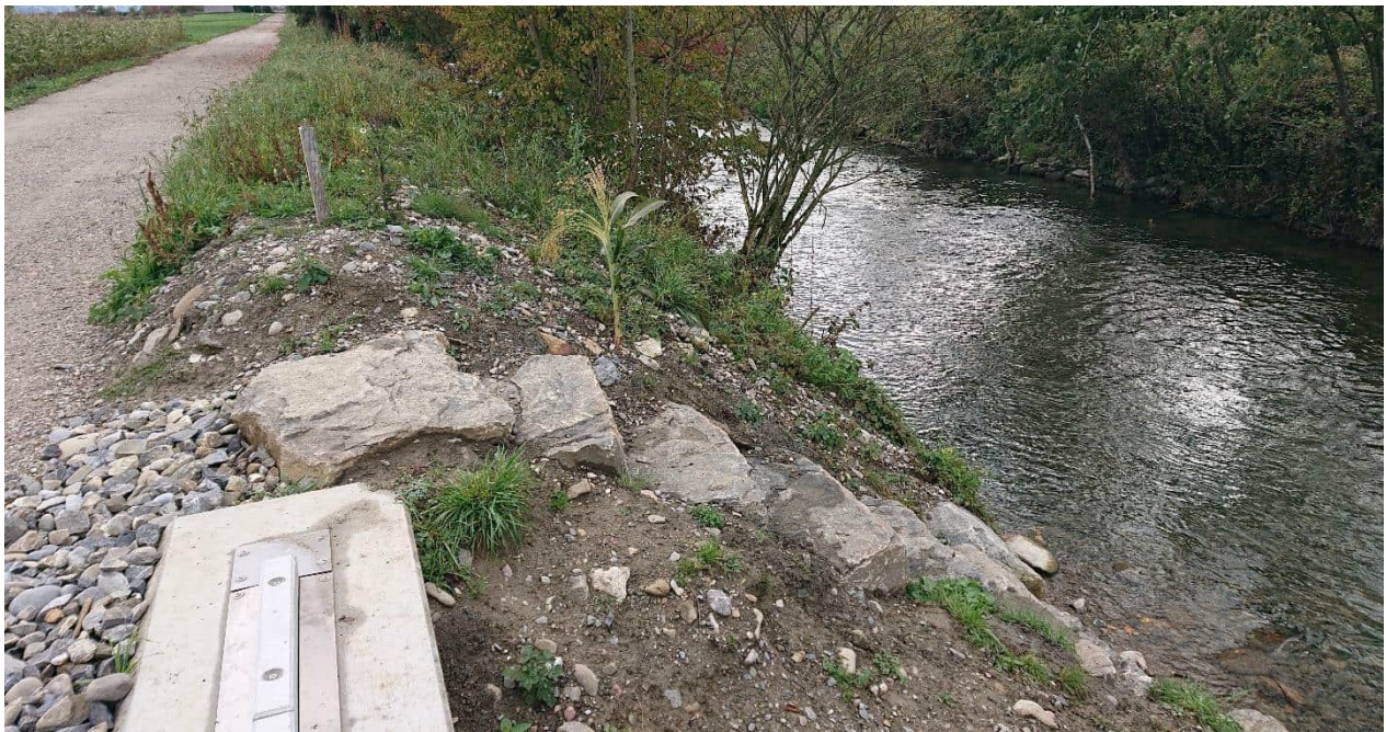
Abbildung 4 Anschauungsbeispiel einer möglichen Ausgestaltung eines Notausstiegs
